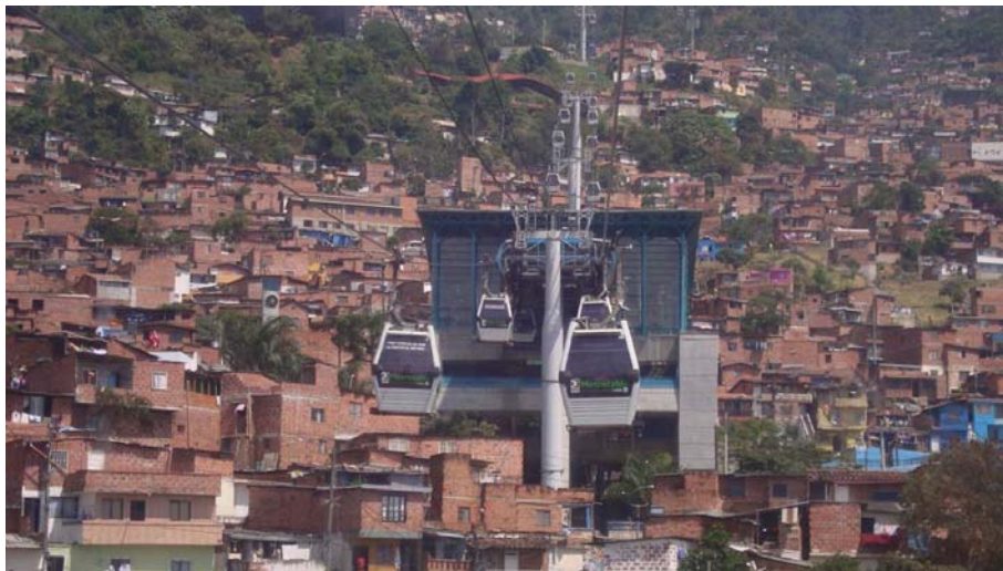
Abb. 12: Seilbahnstation Andalucía der Linie K (FIEBERG 2012)
