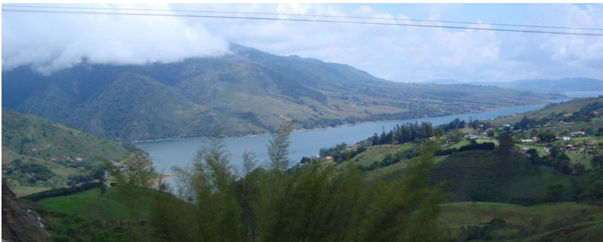
Abb. 9: Der Calima-Stausee (FIEBERG 2012)
