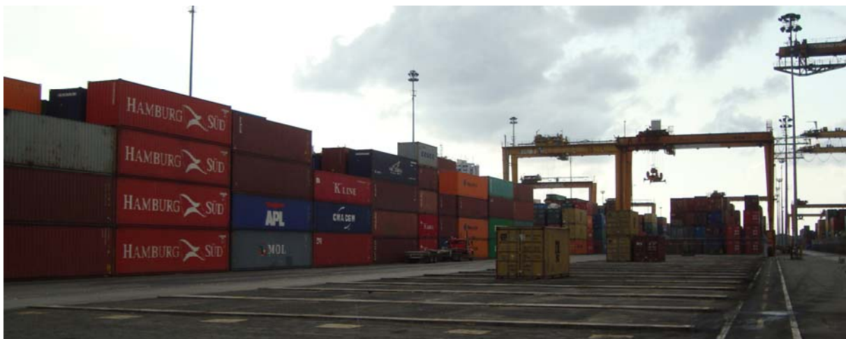
Abb. 10: Containerterminal im Hafen von Buenaventura (FIEBERG 2012)
