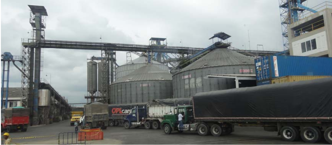
Abb. 11: Siloanlagen im Hafen Buenaventura (BETTIN 2012)
