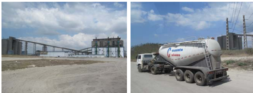
Abb. 9: Zementfabrik (links) (SCHILLING 2013) und LKW der Cementos Cienfuegos (SCHILLING 2013)
