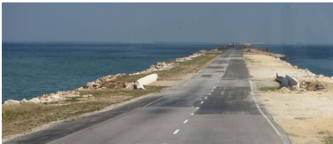
Abb. 13. Pedraplén in Richtung Cayo Coco mit Überbrückung (PICARD 2013)
