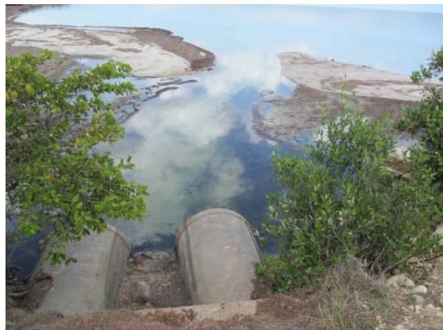
Abb. 15. Sedimentation in Nähe von Durchlässen (SUWALA 2013)
