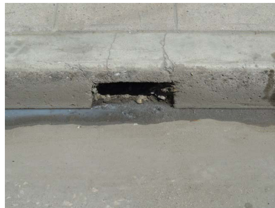
Abb. 6. In Bordstein eingelassenes Abflussrohr (links) und Öffnung (rechts) (JACHE 2013)
