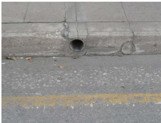
Abb. 6. In Bordstein eingelassenes Abflussrohr (links) und Öffnung (rechts) (JACHE 2013)
